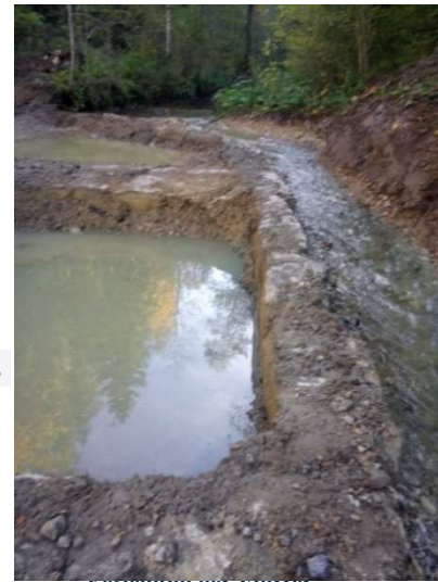
Verlegung des Flusses
